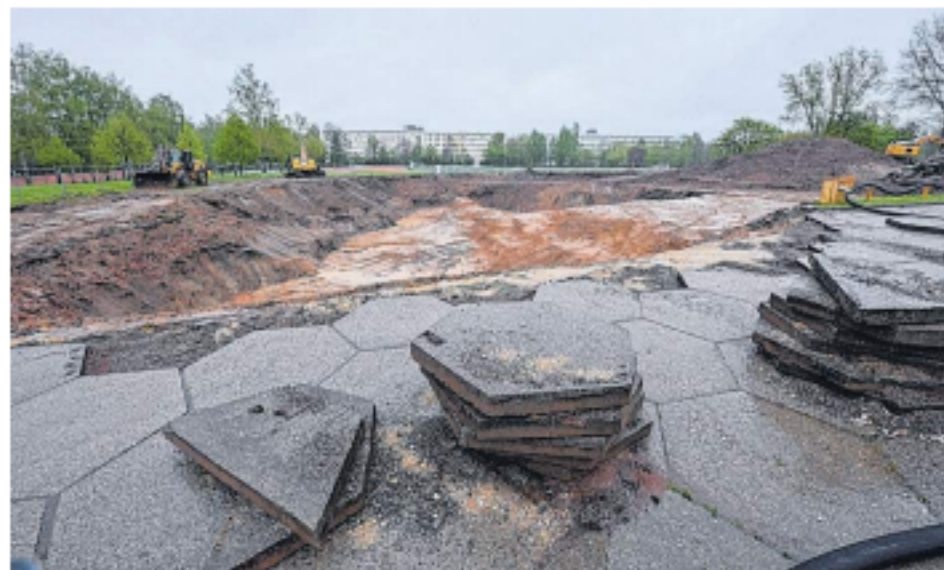
Die Arbeiten für eine der aktuell größten Investitionen in den Universitäts-campus, einen Labor- und Sportkomplex, haben begonnen. FOTO: ANDREAS SEIDEL
